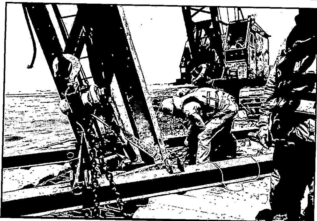
Imagen N°02: Personal realizando trabajos con su respectivo equipo de protección personal
