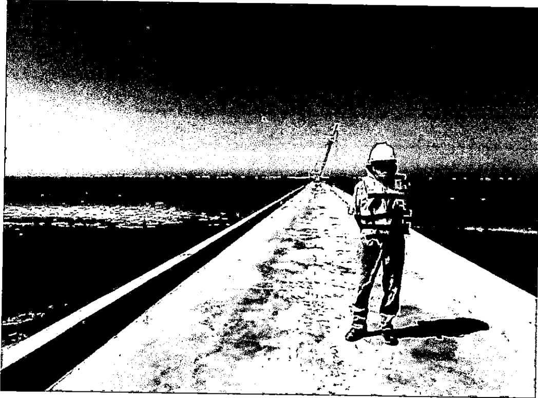
Jefe de Supervisión en muelle a la altura del eje 128
